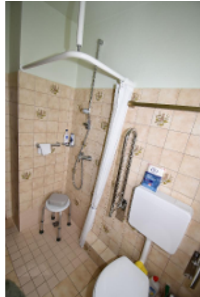
Bodentiefe Dusche im EG
