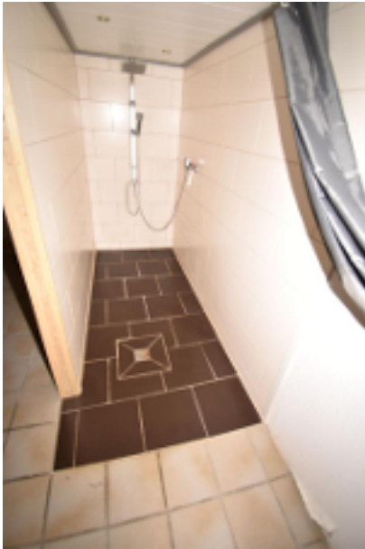
Dusche im Keller
