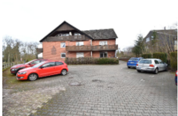
Parkplätze und Seitenansicht
