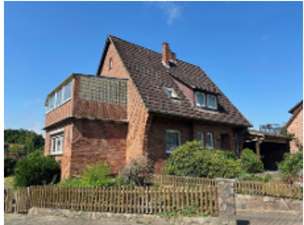
Ansiicht Altbau Straßenseite
