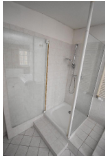
Dusche Bad OG
