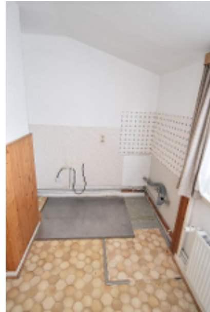
ehemalige Küche OG
